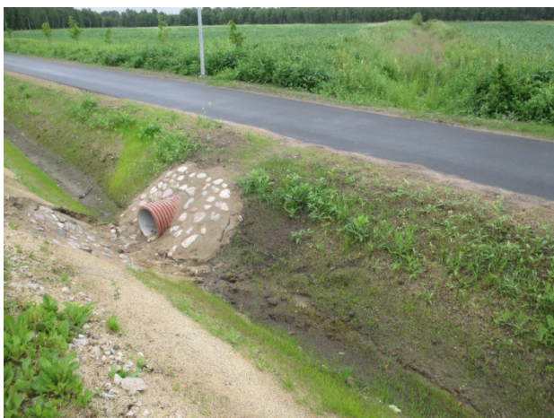
Foto 4 Olemasolev sademevee kogumiskraav Saha tee ääres sõidutee ja kergliiklustee vahelisel alal
